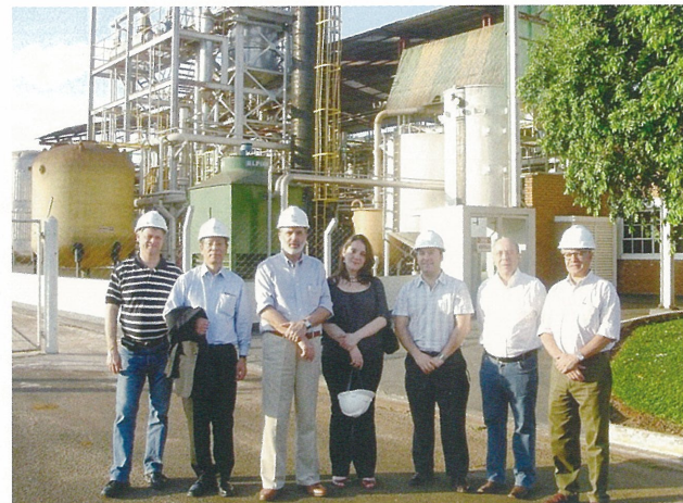
製糖工場のバイオプラスチック・プラント(ブラジル)
