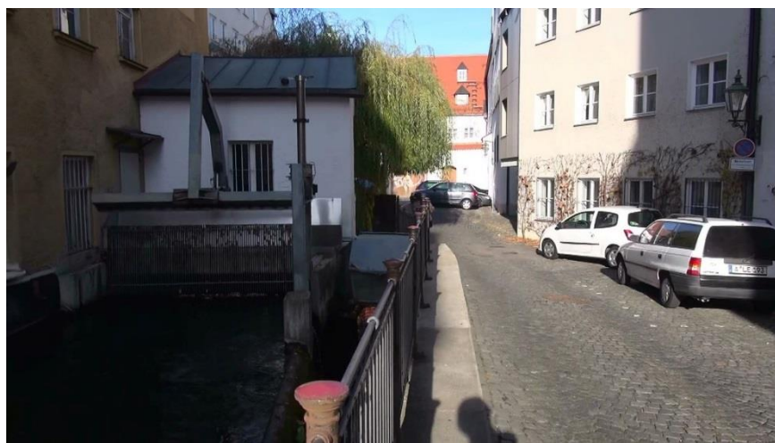
▲ドイツ Augsburg の中心部にある小水力発電施設 (撮影時期 2011年12月)
