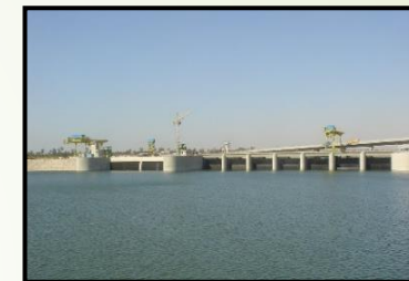
Naga Hamadi Barrage
