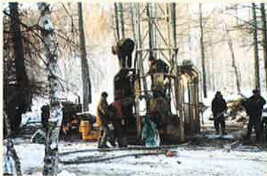
資源探査のためのボーリング風景
