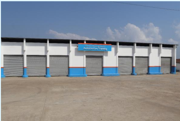
自動車整備トレーニングセンターの改修工事後の様子
