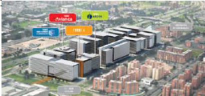
T7/T8 CIUDAD EMPRESARIAL SARMIENTO ANGULO - BOGOTÁ Elevator units: 13 Handover Date: 30/08/2015 Use of the building: Office
