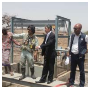
超低落差水力発電実証サイト (エチオピア)
